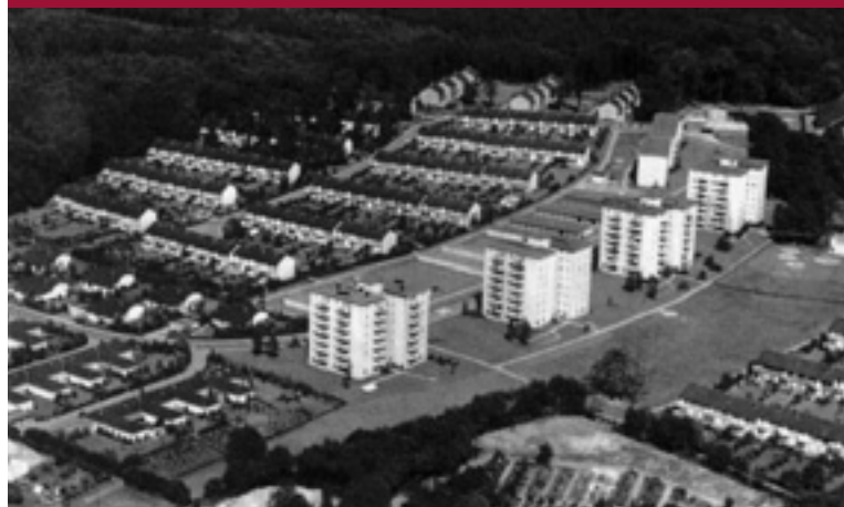
Luftaufnahme der Parksiedlung Kippekausen mit Zeltkirche
