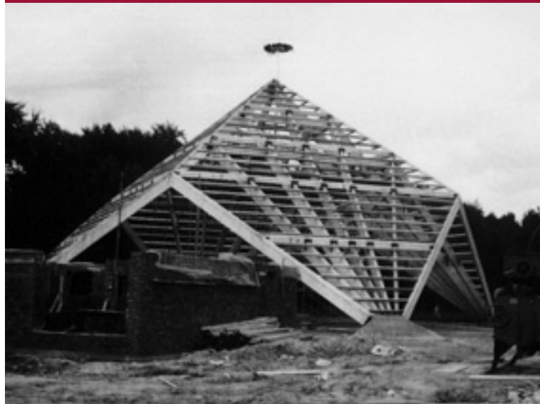
Am 24. Juli 1965 wurde für die Zeltkirche gleichzeitig Grundsteinlegung und Richtfest gefeiert
